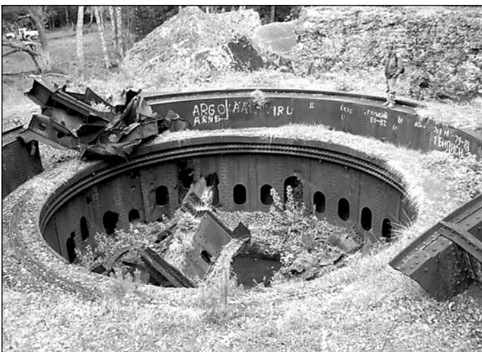
Остатки жесткого барабана второй (левой) башни. 2004 г. Фото предоставил Хейки Муда (Эстония)
