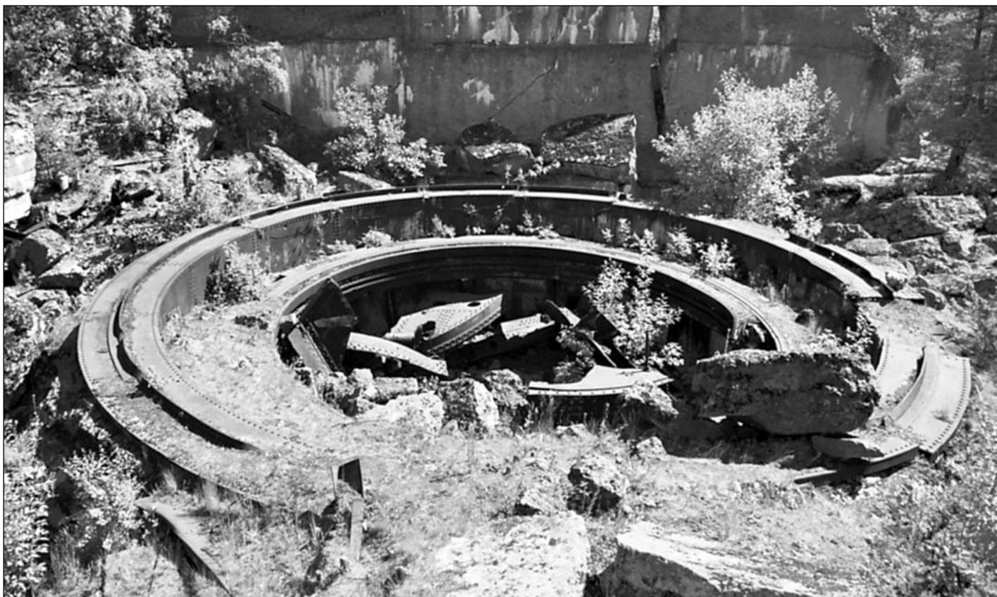
Остатки жесткого барабана второй (левой) башни. На заднем плане видно перекрытие, поставленное взрывом в вертикальное положение. 2009 г. Фото предоставил Максим Трутс (Эстония)
