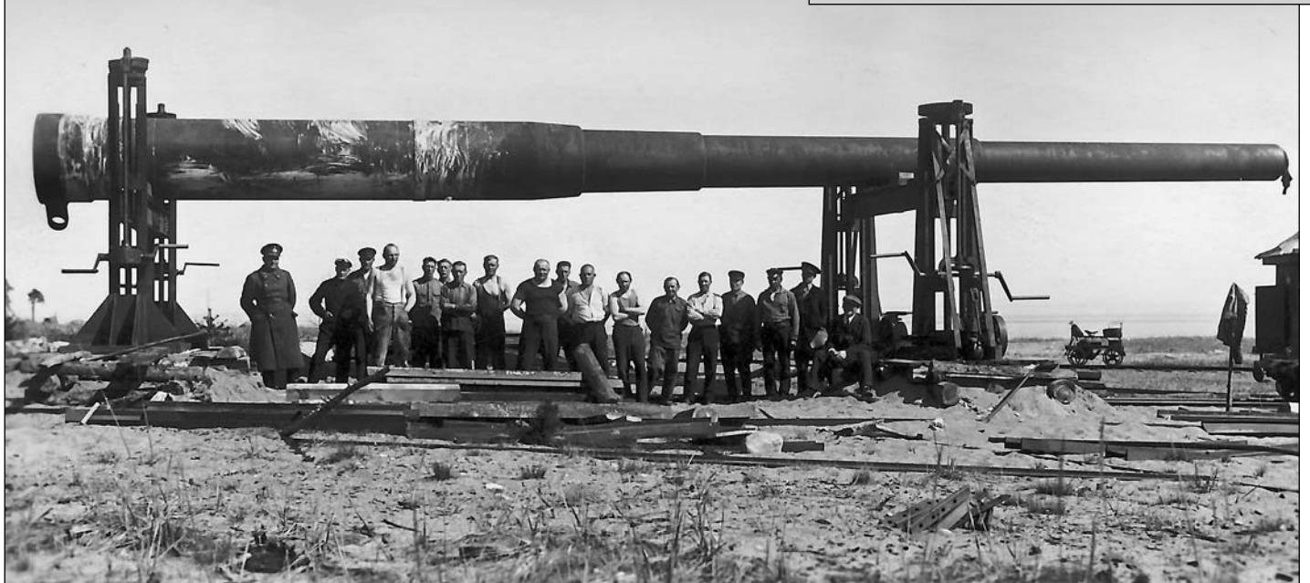
Ствол 12-дм орудия поднят на домкраты для укладки на платформу. 1934 г. Фото предоставил Индрек Лиива (Эстония)
