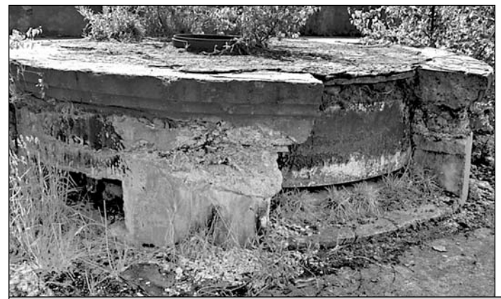
Наблюдательный бронеколпак на крыше блока КП. Бетонирование вокруг колпака было произведено после Второй мировой войны, когда бывший КП батареи №106 использовался для управления огнем находившейся неподалеку 130-мм батарее. 2009 г. Фото предоставил Максим Трутс (Эстония)
