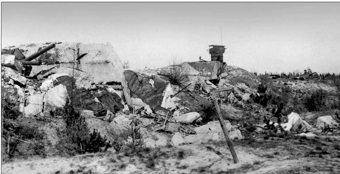
Общий вид батареи №334 после подрыва 28.08.1941 г. Слева направо: вторая башня, блок КП с выдавленной взрывом наверх дальномерной рубкой, первая башня. На дальномерной рубке финны построили наблюдательный пункт для управления артогнем финской 12-дм батареи расположенной на о. Мякилуото. Взорванные орудия смотрят в сторону Таллина. 1942-43 гг. SA Rannarahva Muuseum (Эстония)
