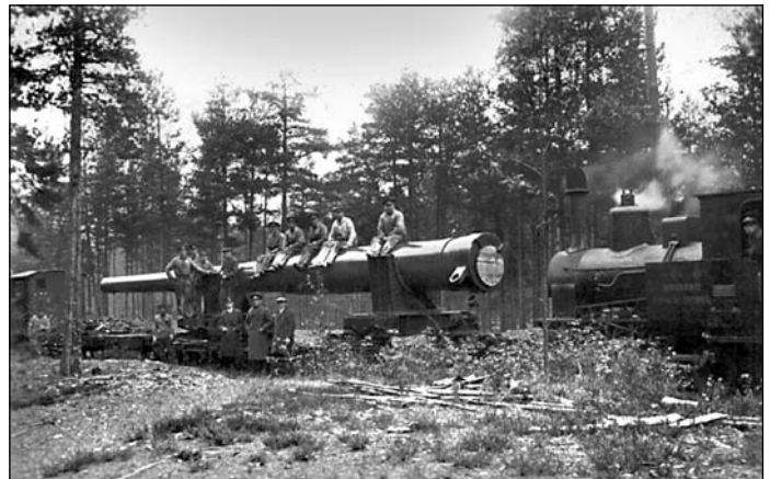
Транспортировка 12-дм ствола по крепостной железной дороге с батареи на склад. Нарген, 1934 г.
