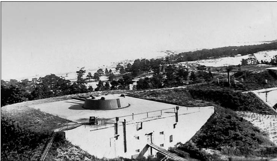
Второй башенный блок. Справа – блок КП, совмещенного с силовой станцией. Блоки получили обсыпку грунтом. Начало 1930-х гг.
