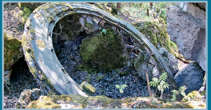
Вывранный взрывом погон вращающейся дальномерной рубки, размещавшейся над КП батареи
