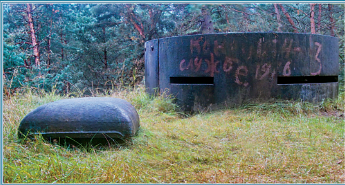
Центральный командный пост комендатуры Аэгна в километре к северо-востоку от позиции батареи. Большой бронеколпак – с батареи №15, а маленький – с башни батареи №106
