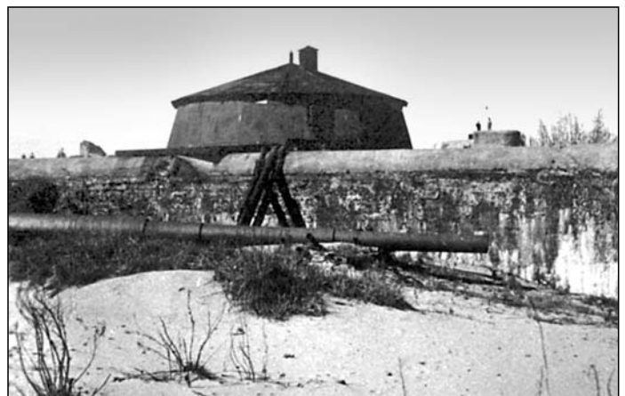
Подготовка к восстановлению второй (левой) башни. На переднем плане ствол 12-дм орудия. Конец 1930-х гг.
