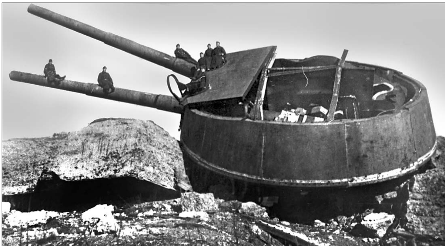
Правая (первая) башня, броневые плиты крыши уже демонтированы. Около 1930 г. Фото предоставил Хейки Муда (Эстония)
